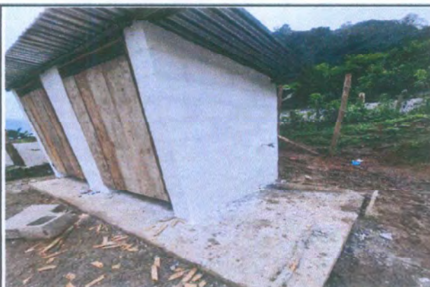
Foto 4: Lámina troquelada calibre 26 en el área de sanitarios
