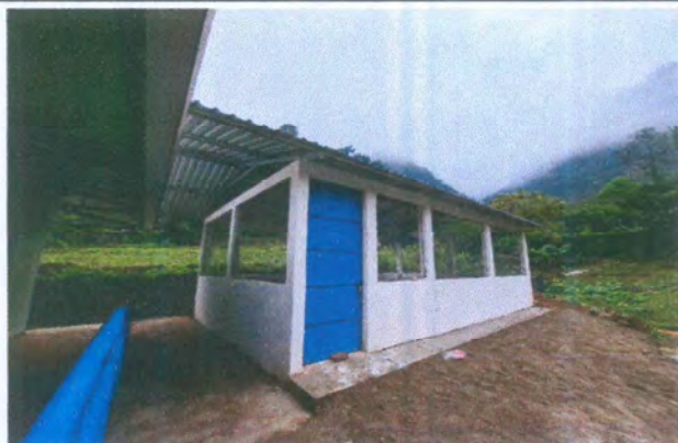
Foto 1: Mejoramiento de estructura tipo pórtico
