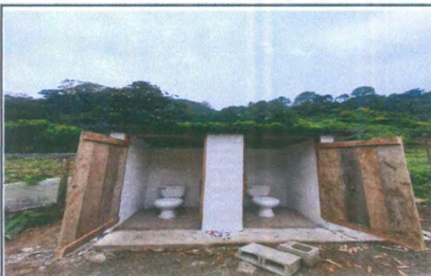
Foto 3: Instalación de piso cerámico antideslizante en el área de sanitarios
