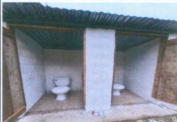
Foto 2: Instalación de un sanitario
