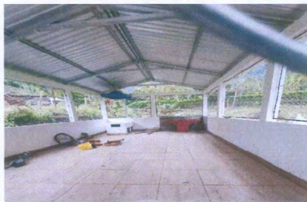
Foto 2: Instalación de lámina troquelada calibre 26
