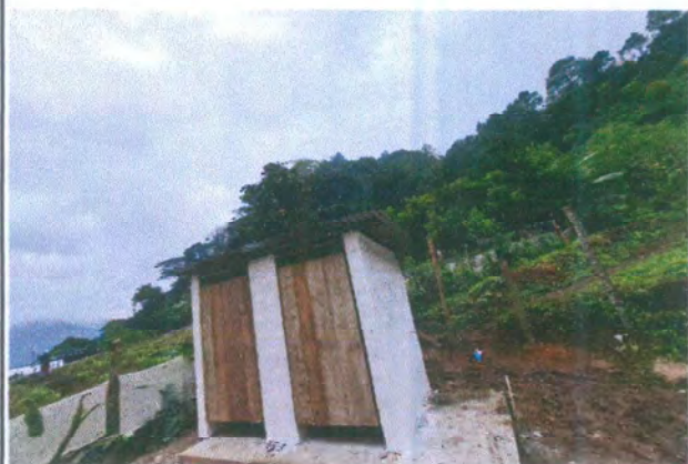
Foto 1: Mejoramiento del área de sanitarios (trabajo adicional)
